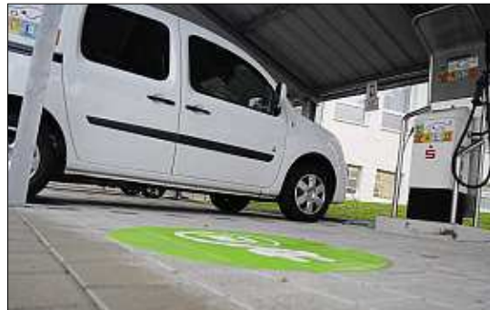
Einsteigen, bitte: Das E-Auto bringt am Sonntag Besucher zum Nahwärme-Heizwerk.
