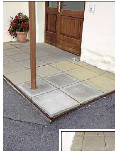
Marode: Rost, Fugen und ein Teil des Sims des Sepp-Stadler-Hauses werden nun erneuert.
